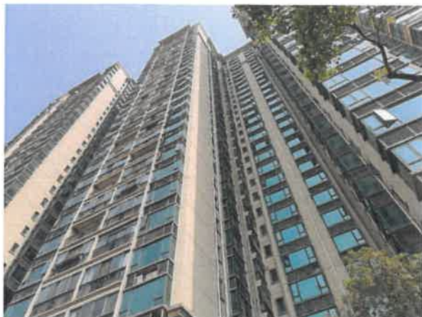
估价对象所在建筑物外观
