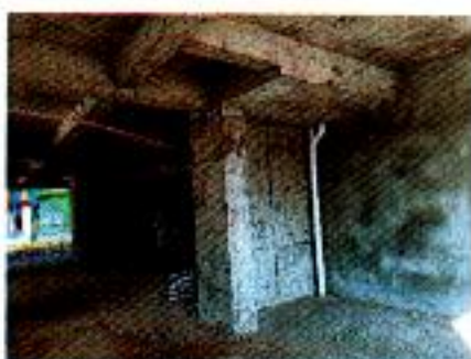
估价对象实物状况
