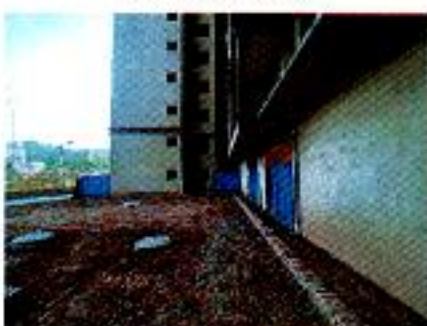
估价对象实物状况
