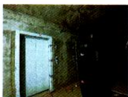
估价对象实物状况
