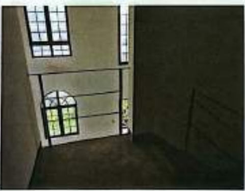
估价对象室内现状
