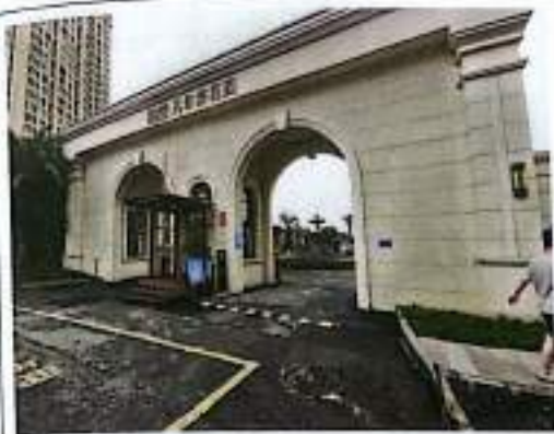
估价对象大门现状
