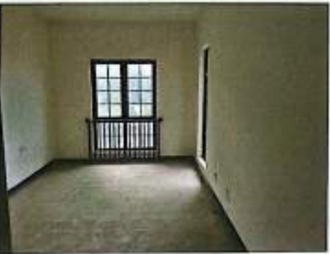
估价对象室内现状
