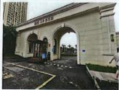
估价对象大门现状
