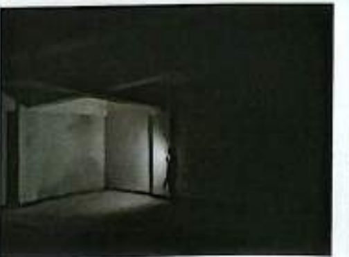
估价对象室内现状
