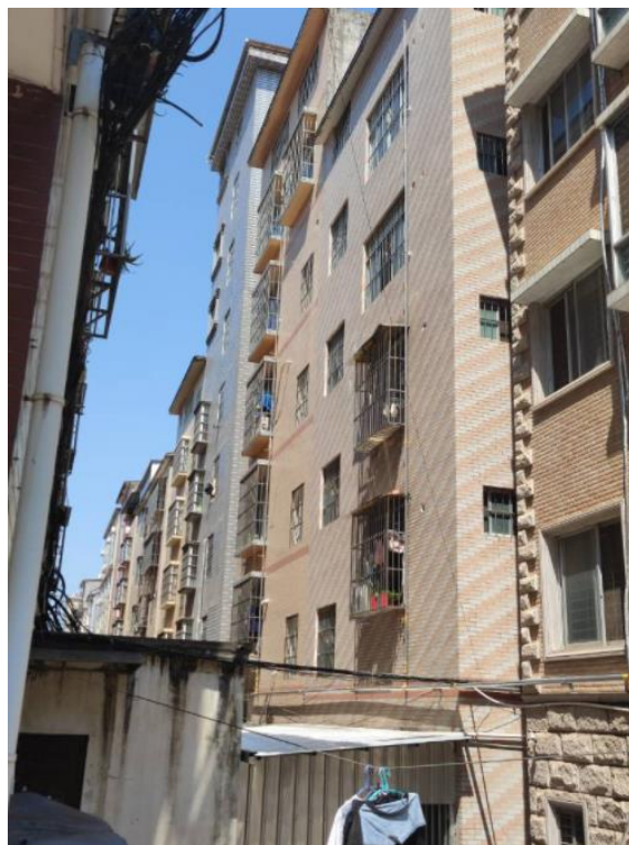
建筑外观背面
