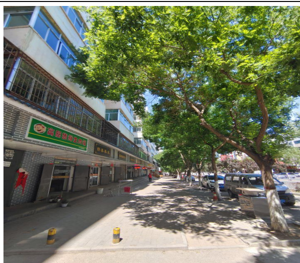
楼栋外观现状
