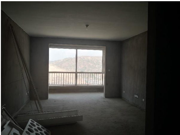
图 5 估价对象内部状况图（1 号楼 1901）
