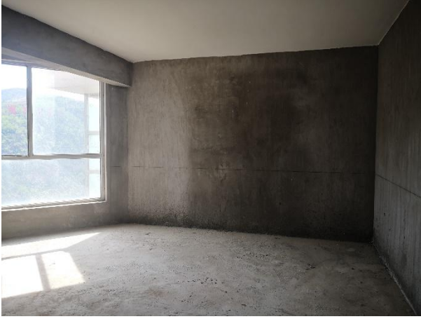
图 1 估价对象内部状况图（3 号楼 1903）
