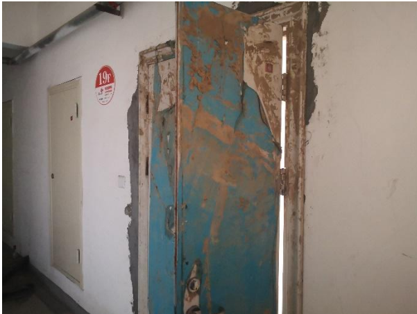
图 3 估价对象房门状况图（4 号楼 1903）
