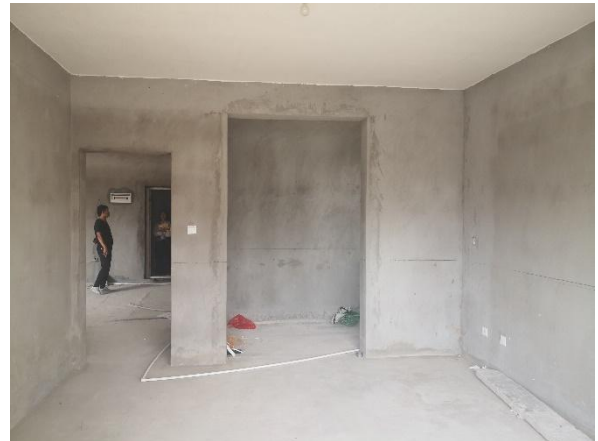
图 4 估价对象内部状况图（4 号楼 1903）
