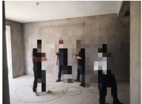
图 4 估价对象内部状况图（1 号楼 2002）
