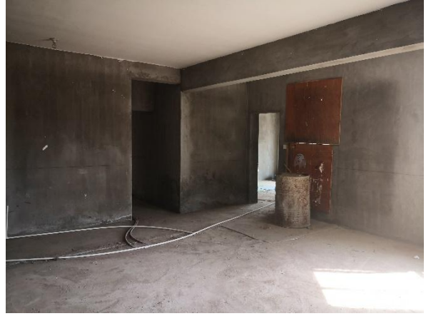
图 2 估价对象内部状况图（3 号楼 1903）
