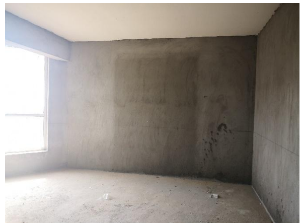
图 6 估价对象内部状况图（4 号楼 1903）
