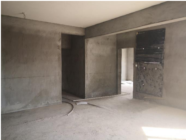
图 5 估价对象内部状况图（4 号楼 1903）
