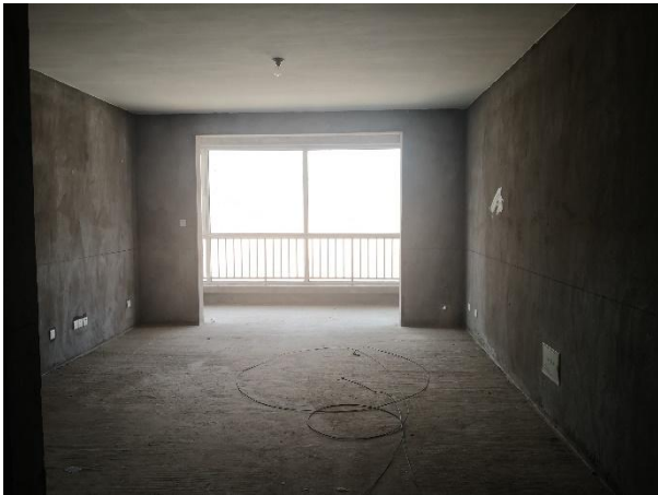
图 3 估价对象内部状况图（1 号楼 2002）
