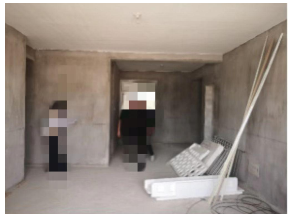
图 6 估价对象内部状况图（1 号楼 1901）
