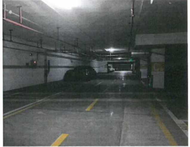
地下室车库现状
