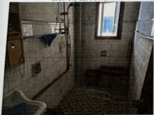
估价对象室内状况
