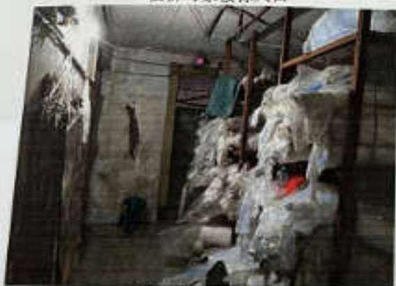
估价对象室内状况
