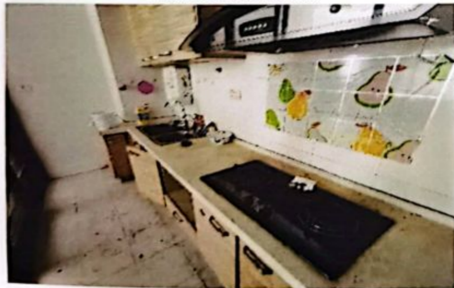
估价对象厨房现状
