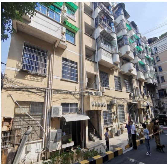
估价对象建筑外立面
