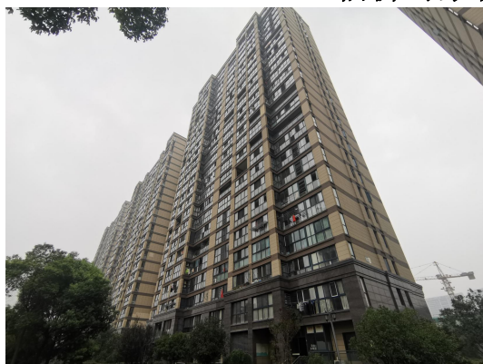
建筑物外立面
