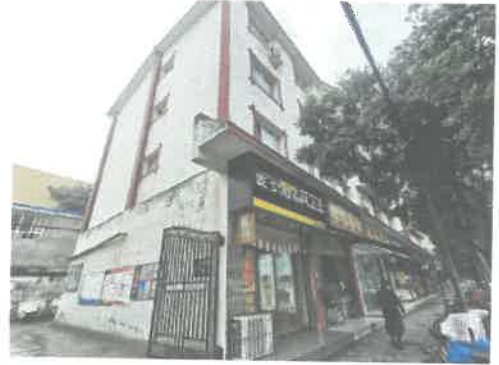
估价对象所在建筑物外观
