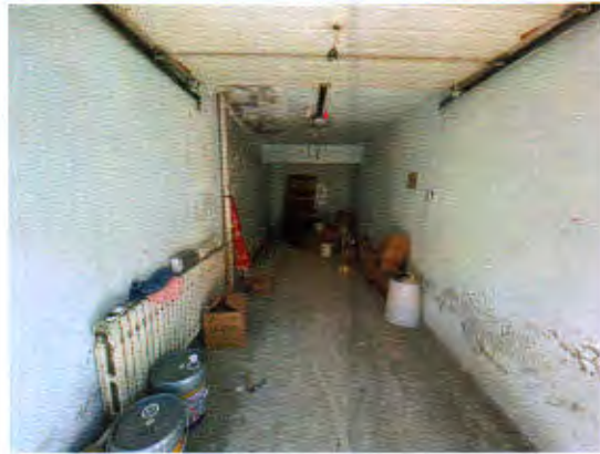
估价对象内部照片
