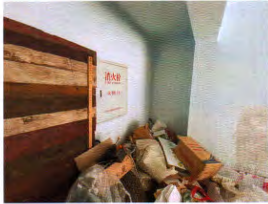
估价对象内部照片
