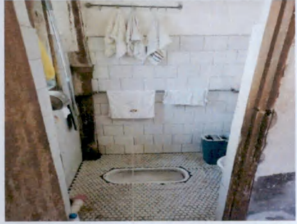
估价对象室内现状
