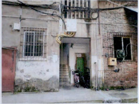
估价对象楼栋入户现状
