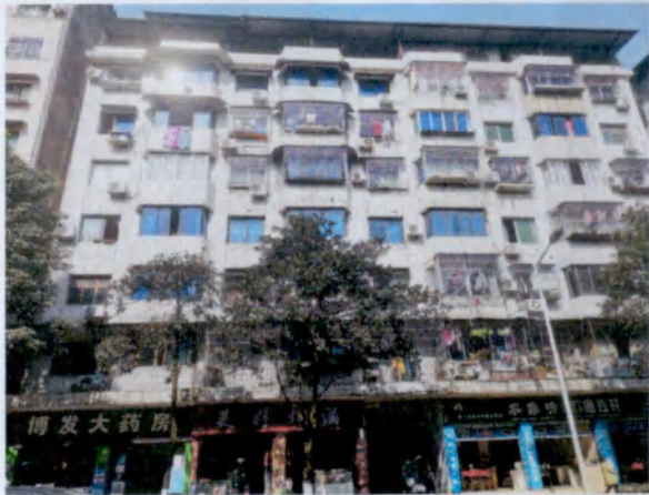
估价对象楼栋外观现状
