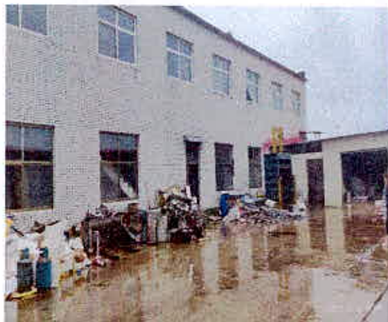
委估对象北面外观照片
