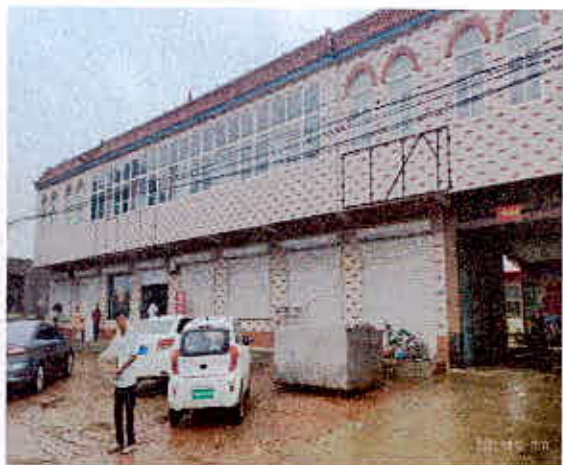
委估对象南面临路外观照片
