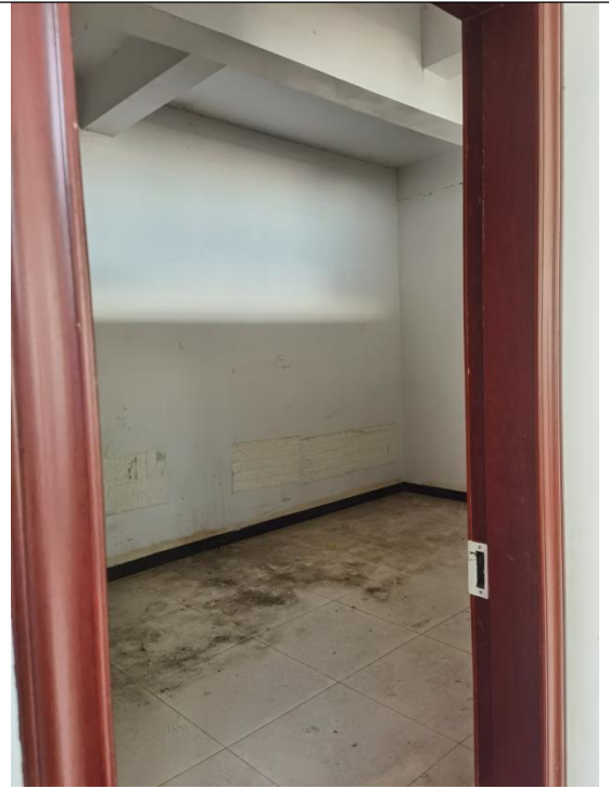
估价对象室内
