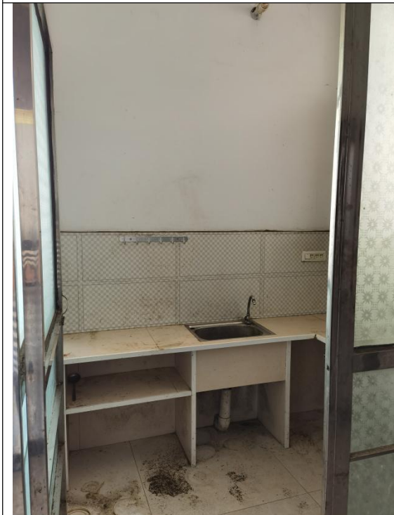
估价对象室内
