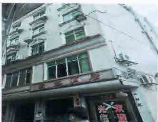
西公路粮所新街外立面
