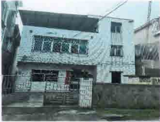
东公路南片房产外立面
