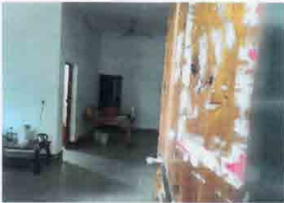
东公路南片房产内观状况
