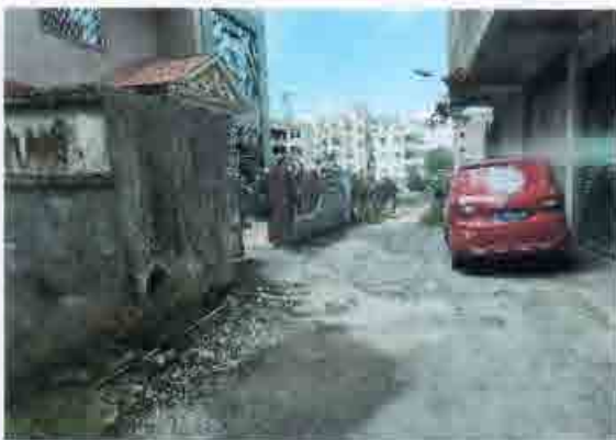
东公路南片房产临路状况
