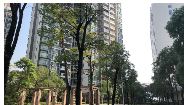
委估对象一所在住宅楼外立面
