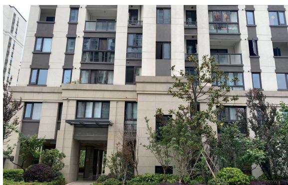
新桥风情小区13幢一单元702室现场照片：
