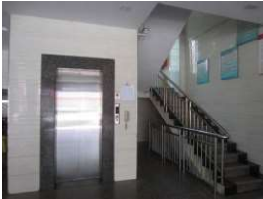
电梯梯间现状
