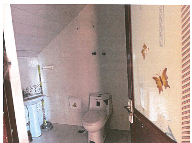
阁楼卫生间状况
