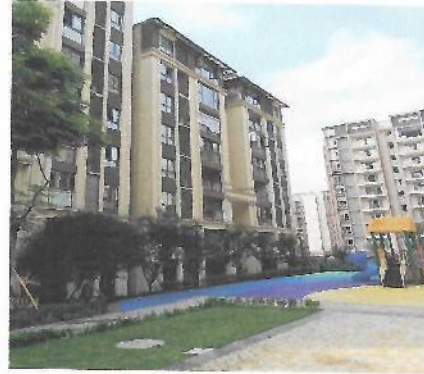
估价对象所在楼
