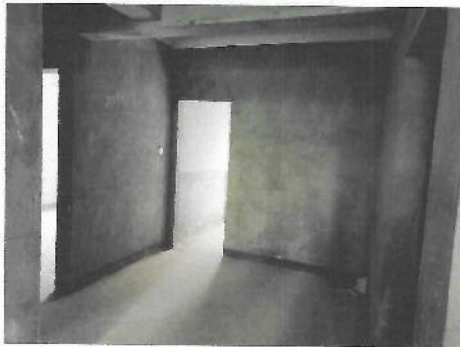
估价对象内部现状
