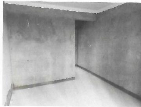
估价对象内部现状
