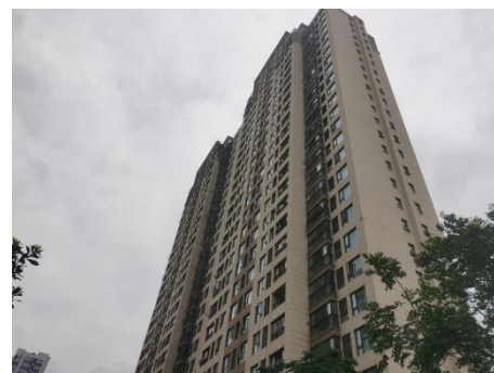
估价对象所在建筑外观
