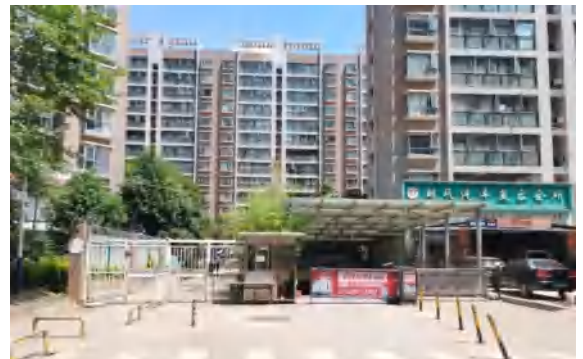
图 4：海运花园 1 号地下室出入口
