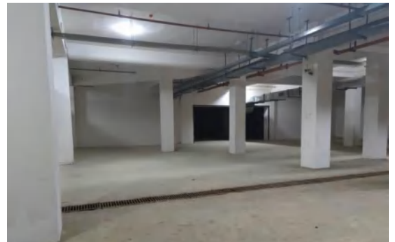
图 4：海运花园 3 号地下室
