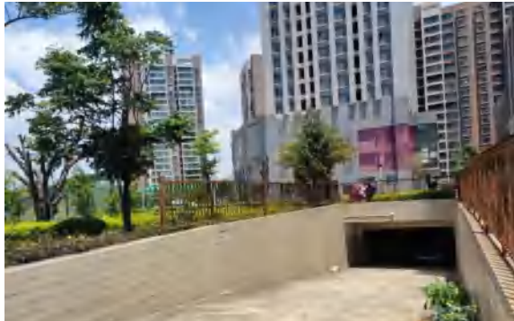
图 1：海运花园 3 号地下室出入口
