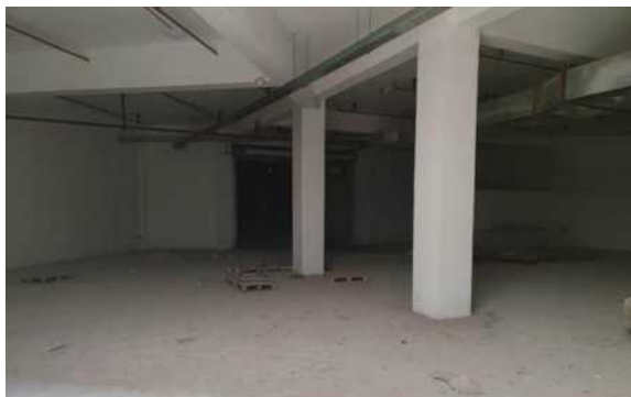
图 3：海运花园 3 号地下室
