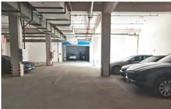
图 3：海运花园 1 号地下室
