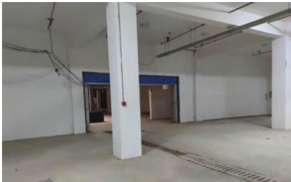
图 5：海运花园 3 号地下室
