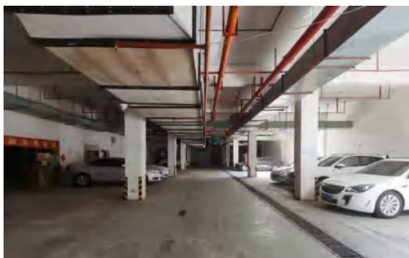
图 7：海运花园 2 号地下室
