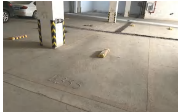
图 6：海运花园 2 号地下室 B355 车位
