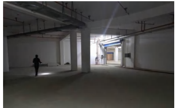
图 2：海运花园 3 号地下室
