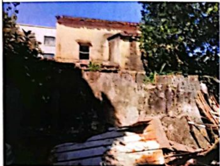
估价对象建筑物状况
