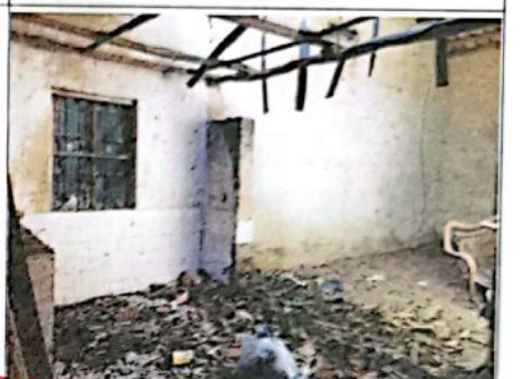
估价对象建筑物状况
