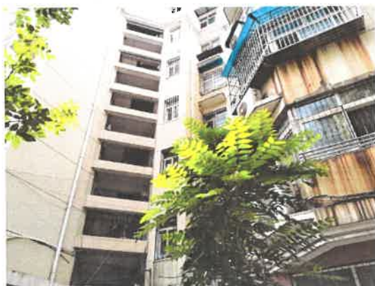
估价对象所在建筑外观
