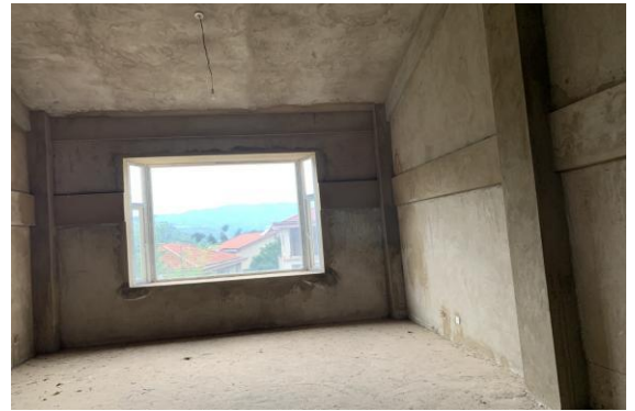
估价对象 1 层内部情况
