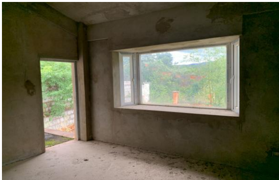
估价对象 2 层内部情况
