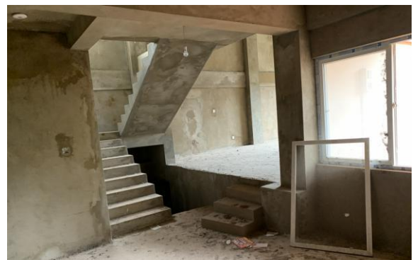
估价对象1层内部情况
