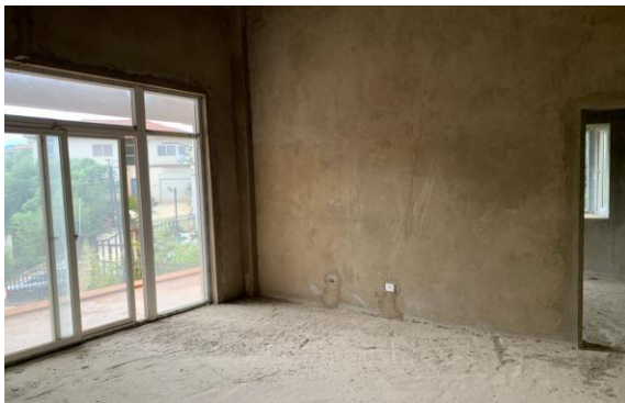
估价对象 2 层内部情况
