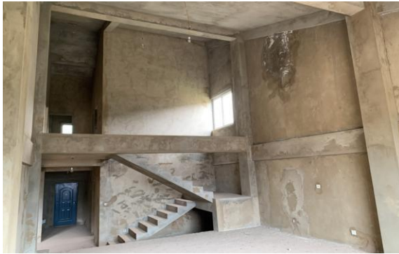
估价对象 1 层内部情况
