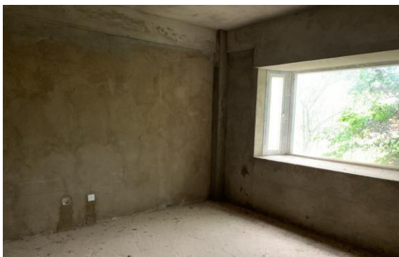
估价对象1层内部情况
