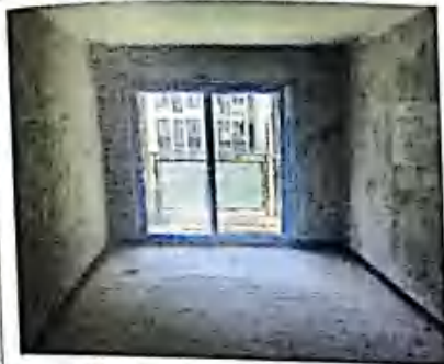
估价对象：室内现状
