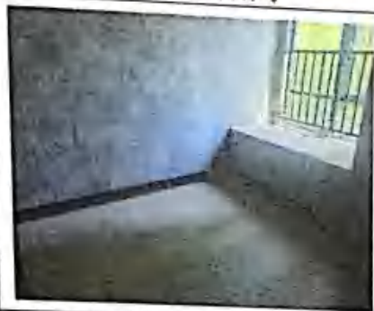
估价对象：室内现状
