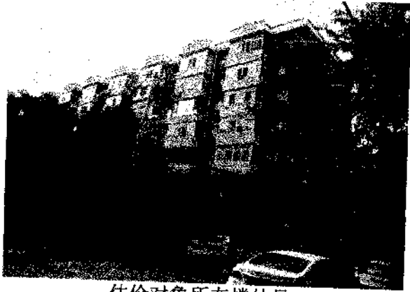
估价对象所在楼外景
