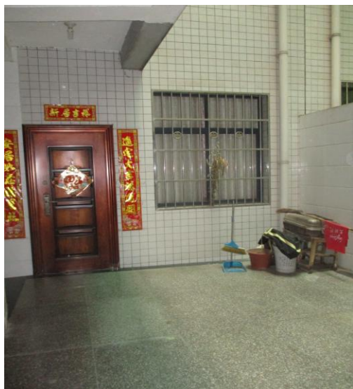
二层住宅外观
