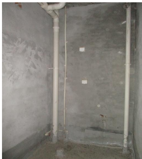
四层至五层住宅公共卫生间室内状况
