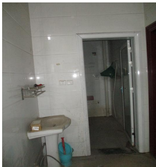
三层住宅房公共卫生间室内状况
