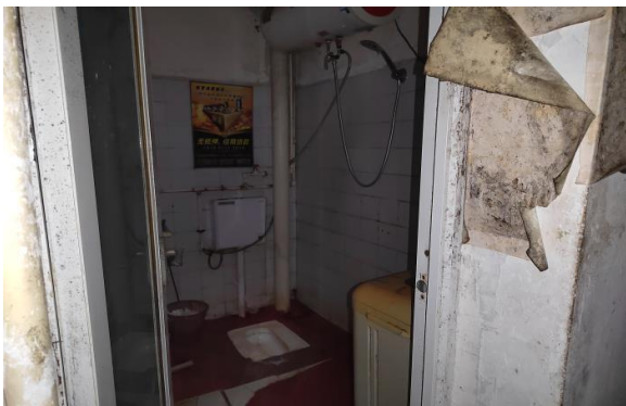
1层卫生间内景
