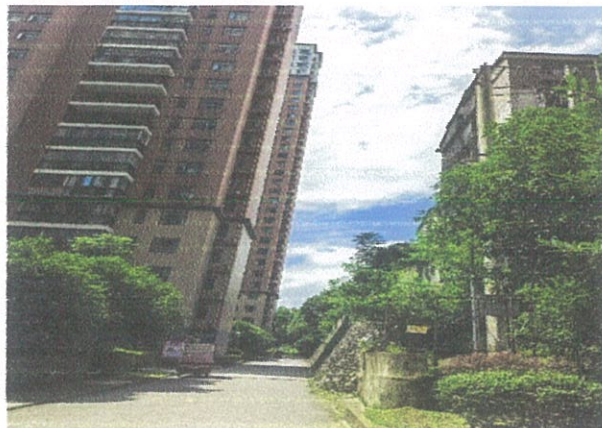
估价对象小区路况
