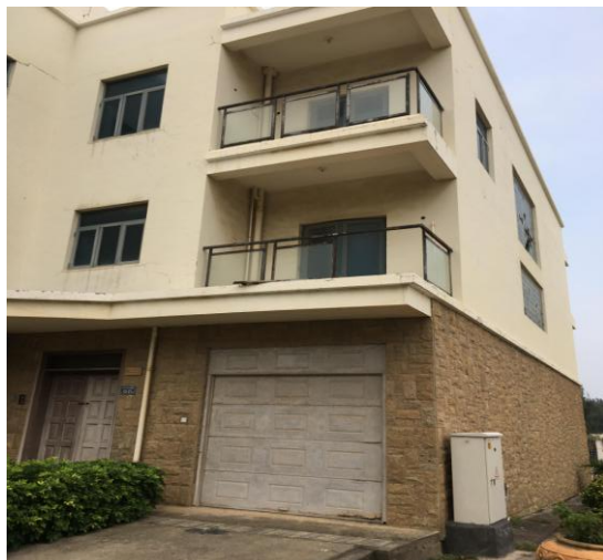
建筑外观（部分）
