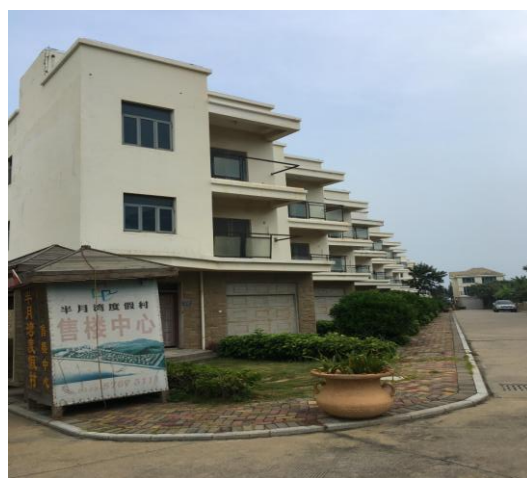
建筑外观（部分）
