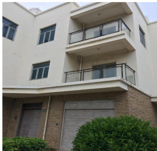
建筑外观（部分）
