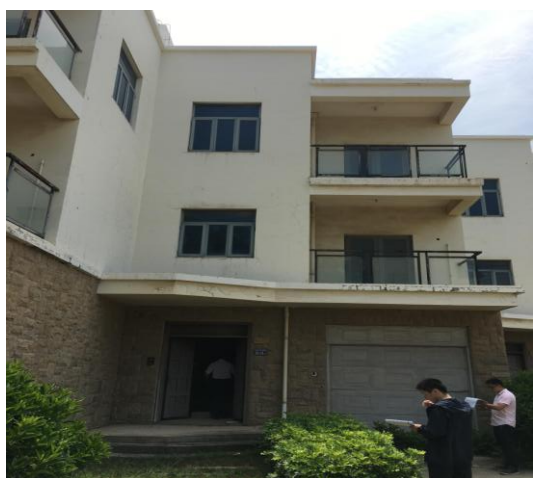
建筑外观（部分）
