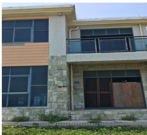
建筑外观（部分）
