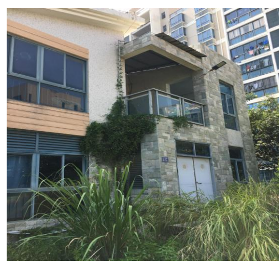
建筑外观（部分）
