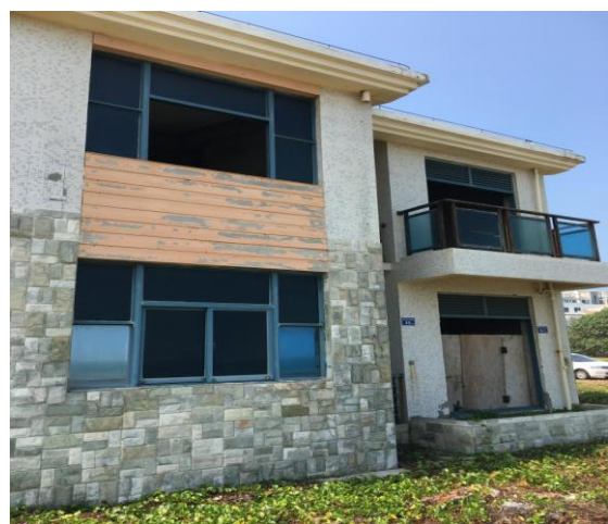
建筑外观（部分）
