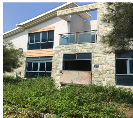
建筑外观（部分）
