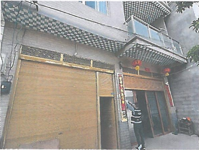
估价对象楼栋出入口
