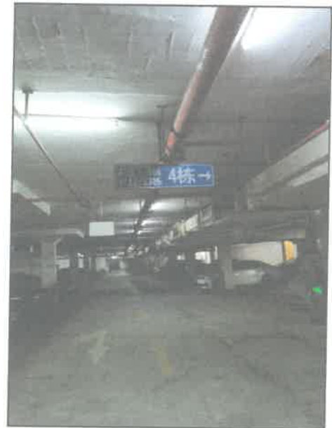
地下车库内景
