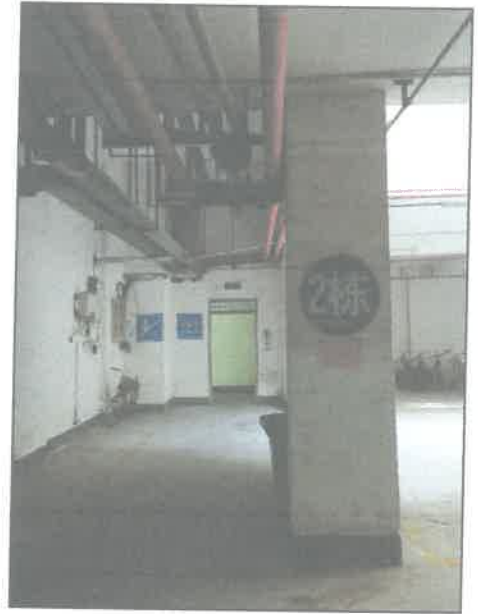
地下车库内景
