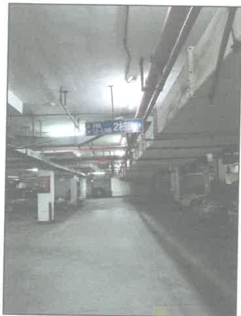
地下车库内景
