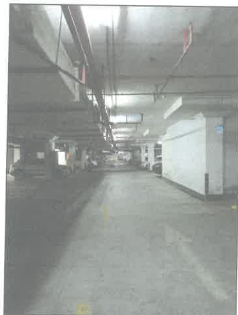
地下车库内景
