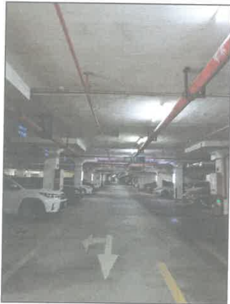
地下车库内景
