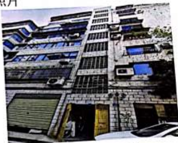
估价对象大楼现状
