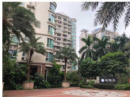
所在住宅楼外立面
