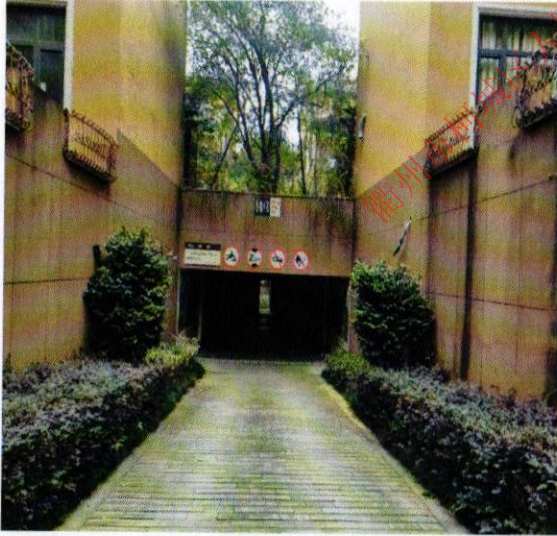
估价对象地下车库入口
