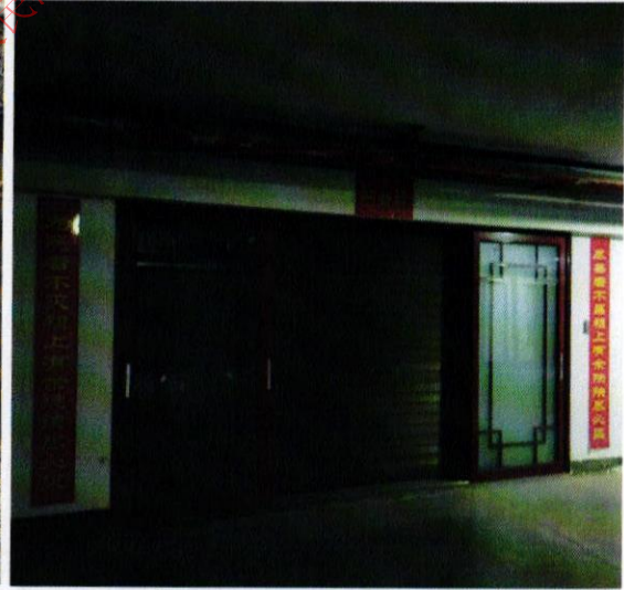
估价对象地下车库大门
