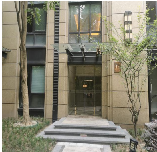
估价对象单元入口
