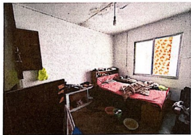
估价对象内部照片
