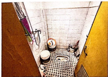
估价对象内部照片
