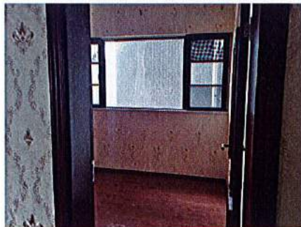
估价对象室内状况
