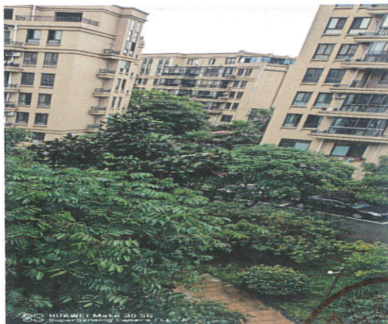
估价对象所处楼栋外观
