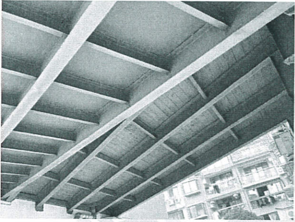
图 5-11: 主钢梁与次钢梁节点连接方式与设计不符, 采用点焊连接, 焊接节点焊缝未满焊、部分存在焊渣情况
