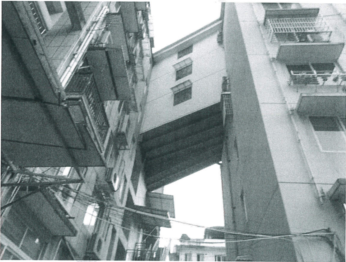
图 1-1：钢结构连廊现状外观图
