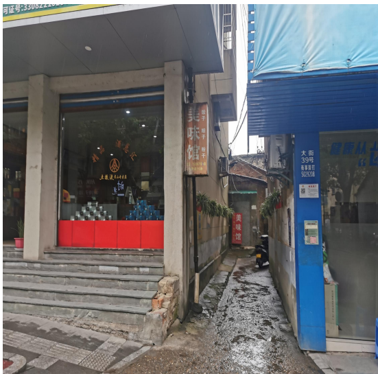
估价对象为民弄通道
