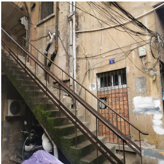
估价对象单元入口
