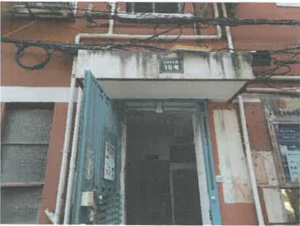
估价对象单元入口
