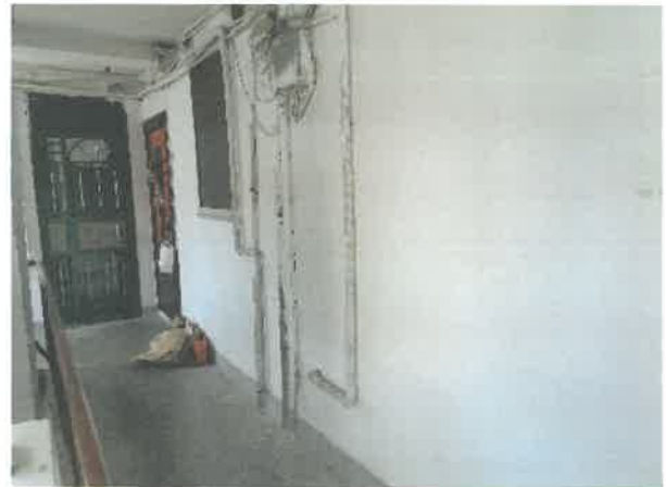
估价对象楼梯间
