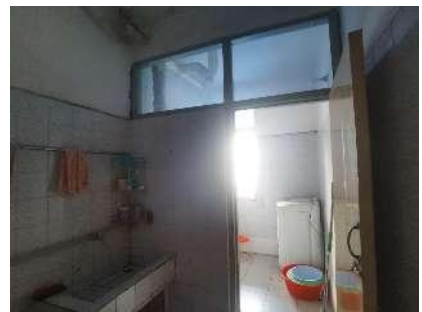
◆ 估价对象室内状况
