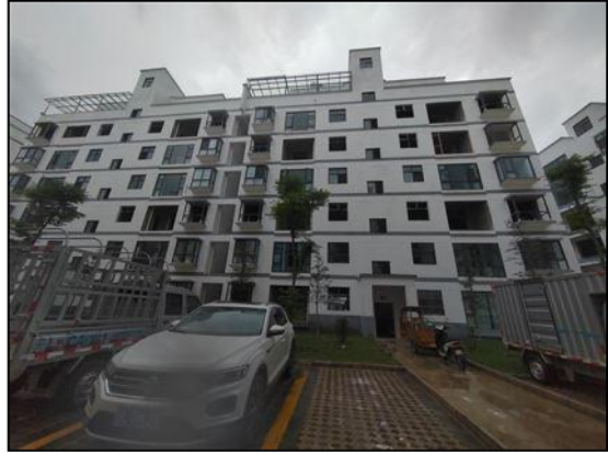
建筑物外观状况
