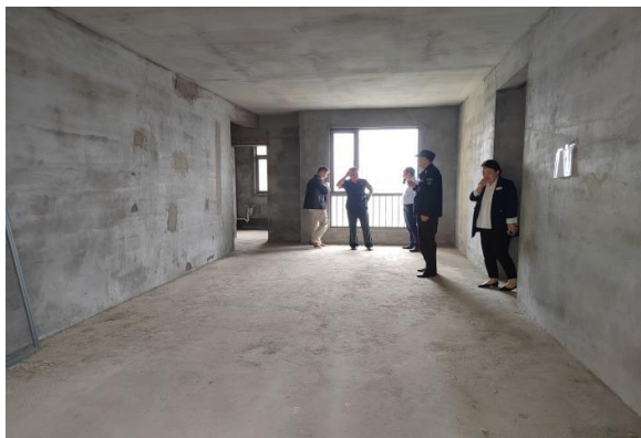
客厅、餐厅现状
