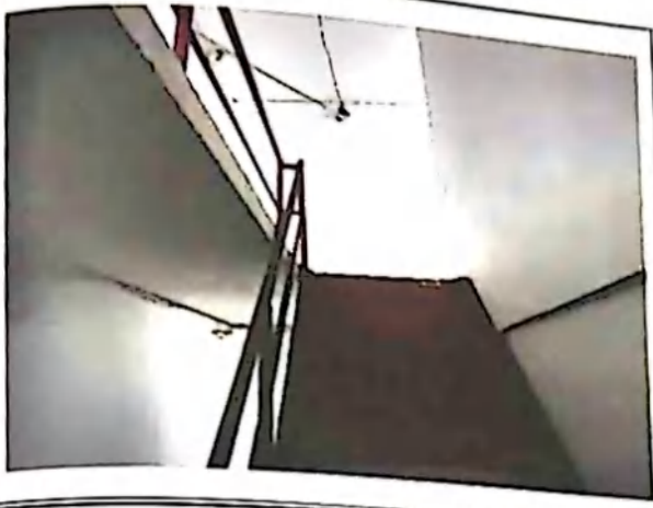
估价对象内部现状
