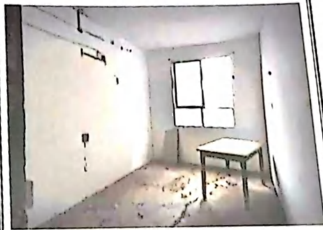
估价对象内部现状
