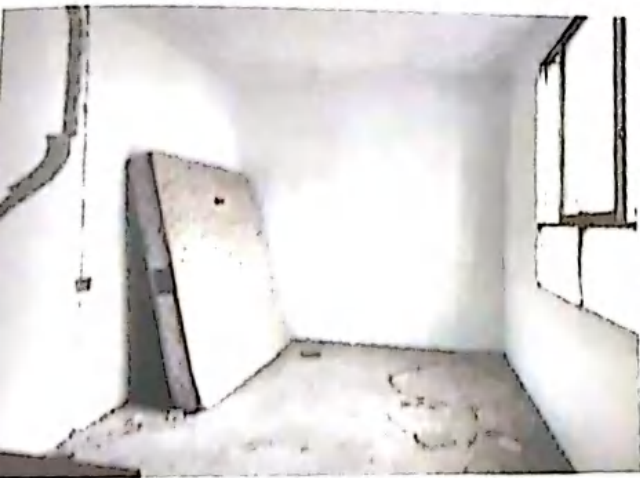
估价对象内部现状
