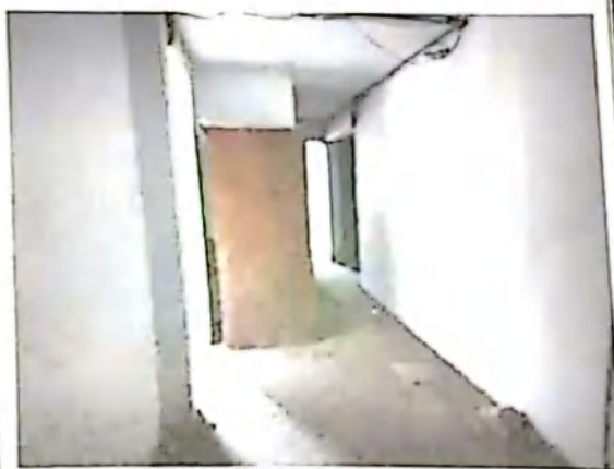
估价对象内部现状
