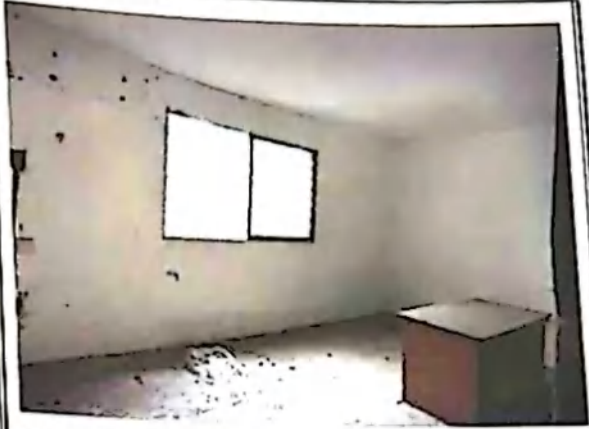
估价对象内部现状
