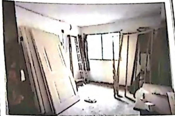
估价对象内部现状
